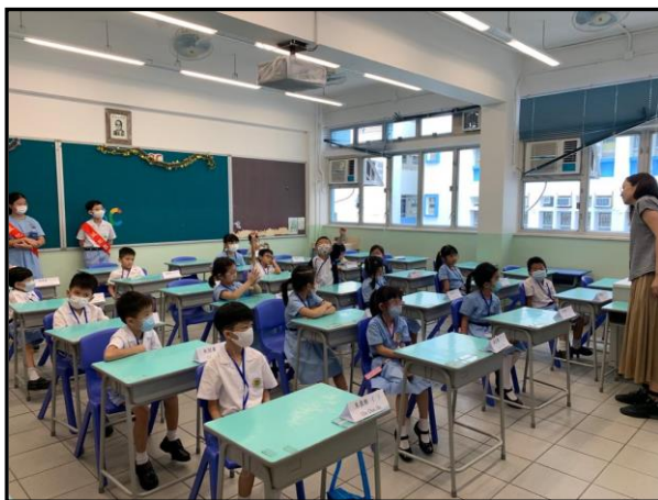
三樓各個課室已更換 LED 光管 以改善照明系統
